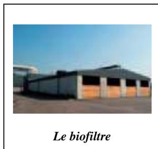
Il est important de signaler que la nuisance olfactive produite par les déchets organiques traités est réduite en aspirant l'air dans tous halls fermés de l'usine. Cet air est lavé et reconduit vers un *système de biofiltre* couvert (12). Néanmoins, il faut tenir compte que même si les odeurs sont contrôlées, cette nuisance n'est pas éliminée complètement. Ceci, constitue un point très important au moment d'évaluer la localisation éventuelle d'une installation.
